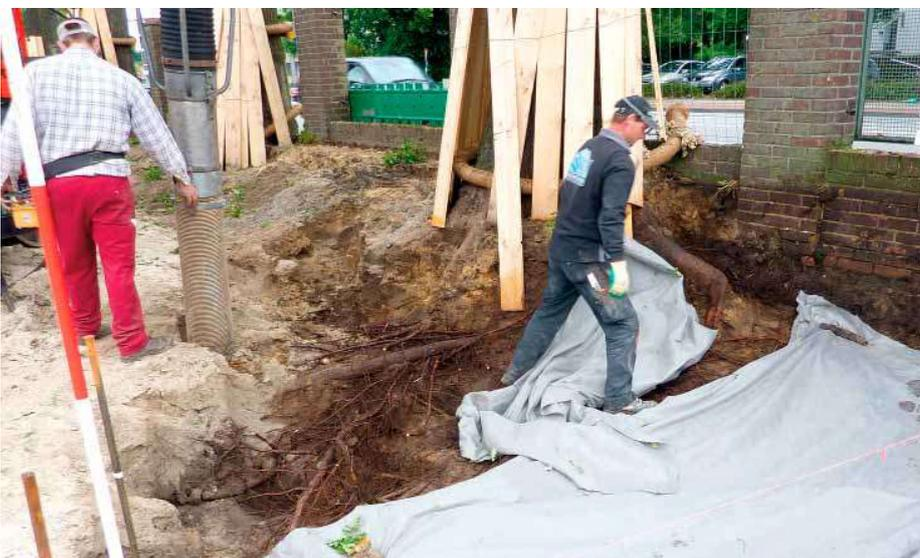
Der Sandboden wurde mit einem Saugbagger abgesaugt. Um weitere Wurzelschäden zu vermeiden, wurden die verbliebenen Wurzeln mit einem Vlies abgedeckt und feucht gehalten.
