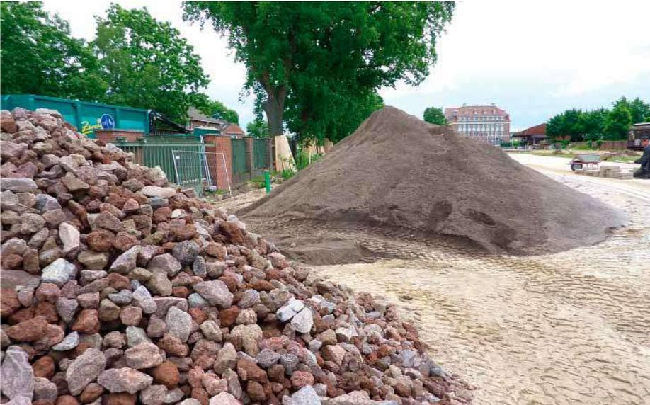
Im Bildvordergrund liegt das „Stützkorn“ des „unverdichtbaren“ Substrats, dahinter der getrennt angelieferte „Feinboden“, das Bims-Xylit-Gemisch. Links die zu sanierenden Eichen und die Mauer, zur Straße hin.
