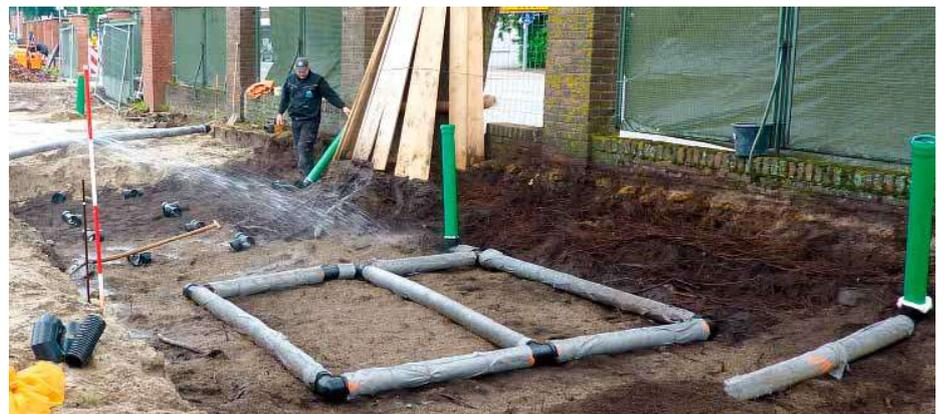
Die Belüftungs- und Bewässerungselemente bestehen aus druckstabilen, mit Geo-Textil ummantelten Dränagerohren. Sie wurden mit Bims-Xylit-Gemisch, etwa 10 cm stark, abgedeckt.
