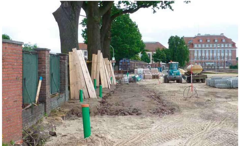
Die grünen, senkrecht stehenden Rohre sind die Verbindung zu den Belüftungs- und Bewässerungselementen und werden oberflächengleich abgeschnitten und mit einer weitgehend offenen Abschlusskappe versehen.
