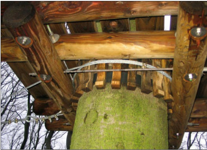
Abb. 5: Befestigung einer Plattform sowie eines umschlingenden Stahlseils in einer Belastungsebene
