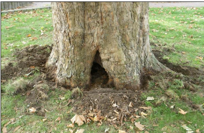
Mächtige Platane, die auf einem Spielplatz im Ruhrgebiet steht. Der Stammfuß weist auf seiner Südseite eine tiefe Stammfußöffnung auf. Seitlich der Stammfußhöhle sind kräftige Wurzelanläufe mit jeweils steilem Abgangswinkel zu erkennen. Weitere Schadmerkmale lassen sich nicht erkennen.
