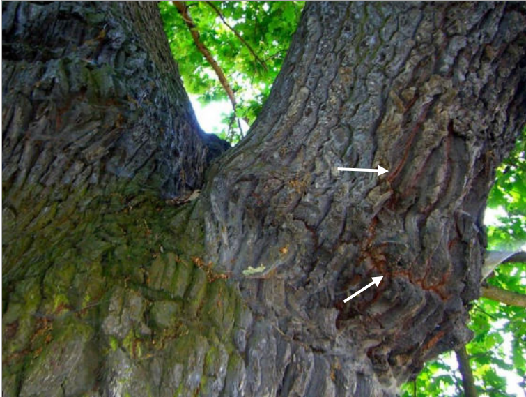
Abbildung 18 Da Bäume lebende Konstruktionen sind, reagieren sie auf Beschädigungen und Statikprobleme. Nimmt die Versagensgefahr zu, verstärkt sich die Deutlichkeit der Reaktionen. Bei der abgebildeten Eiche liegt eine umfassende Ausfaltung des rechten Stämmlings vor. Mit zunehmendem Holzabbau wurde die Unterseite des Stämmlings immer stärker belastet. In der Folge kam es zu stetig stärker werdenden Stauchungen des Materials. Zusätzlich bildete sich das Phänomen der panikartigen Dickenwüchse aus (Pfeile), sodass dringender Handlungsbedarf gegeben war. Maßnahmen: Kronenteileinkürzung um 2,5 m und Einbau einer Trag-/Haltesicherung.
